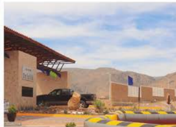
Conclusión de la construcción del salón de usos múltiples y caseta de vigilancia
