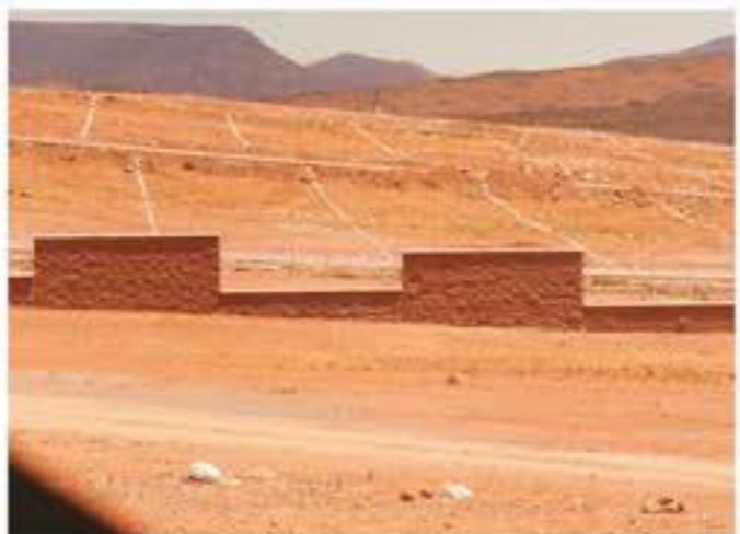
Muro perimetral en Clúster 3 al 12 (Mampostería, Muro de block, Reja metálica Cadena de cerramiento)
